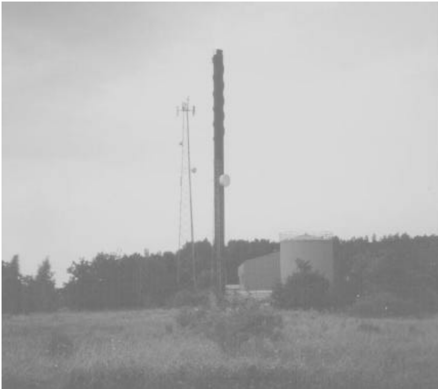
Exempel på placering av antennmaster i anslutning till värmeanläggning.
